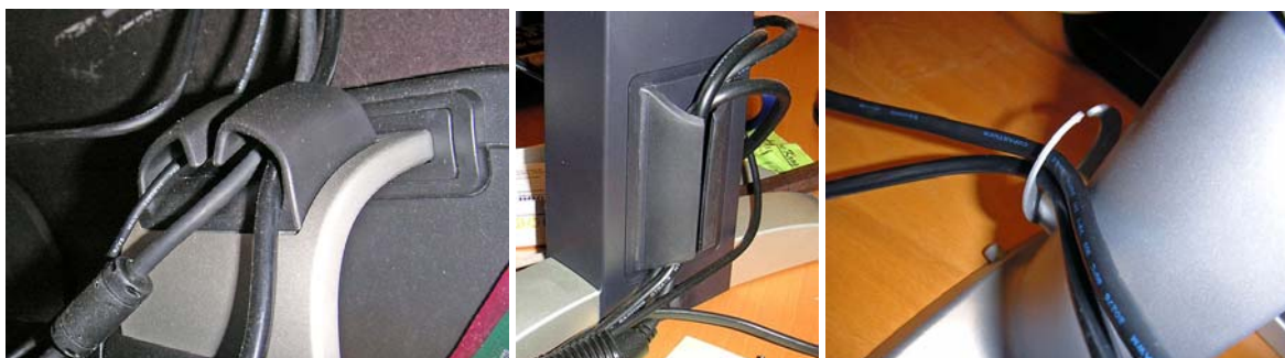
Figur 78-80: Exempel på kabelavlastare på monitorer Vänster: Dell, Mitt: Dell, Höger: Samsung
