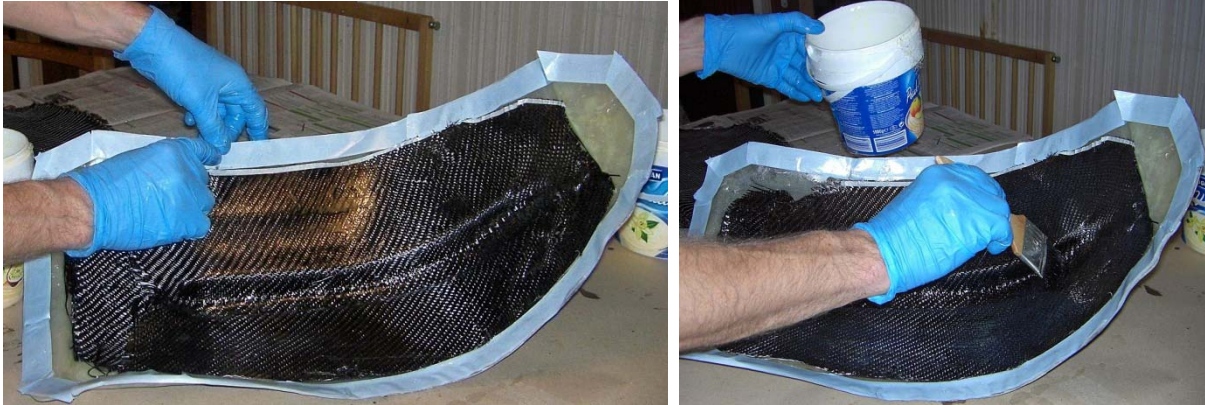
Figur 12-2,a,b: Laminering med vakuumbag, steg 2 och 3
