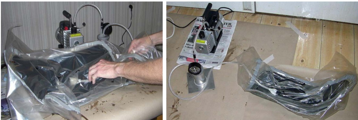
Figur 12-4,a,b: Laminering med vakuumbag, steg 6 och 7
